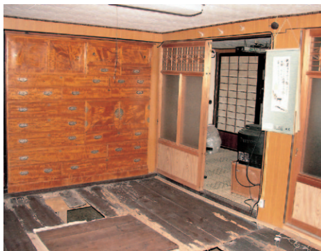
改修が行われた空き家（改修前）
