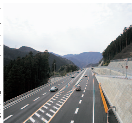
完成した三坂道路
