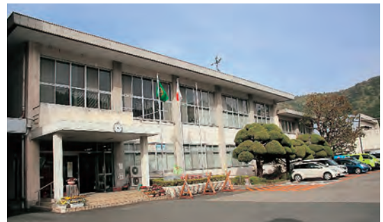
▲松野町旧庁舎（昭和36年建築：60年経過）
