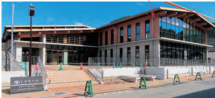
▲松野町新庁舎・防災拠点施設
