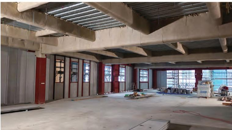
愛媛県自治会館新会館建設工事は、外側足場の組立が完了し、内装工事が進んでいます。写真は、外壁となる外壁パネルの設置と鉄骨梁に耐火被覆材を施行しているものです。
